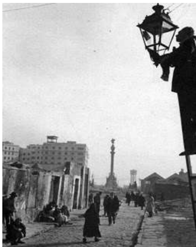
*1953.- Això es el que quedava del carrer del Migdia durant els enderroc per obrir l'avinguda Garcia Morato. (Foto: Josep Postius)
