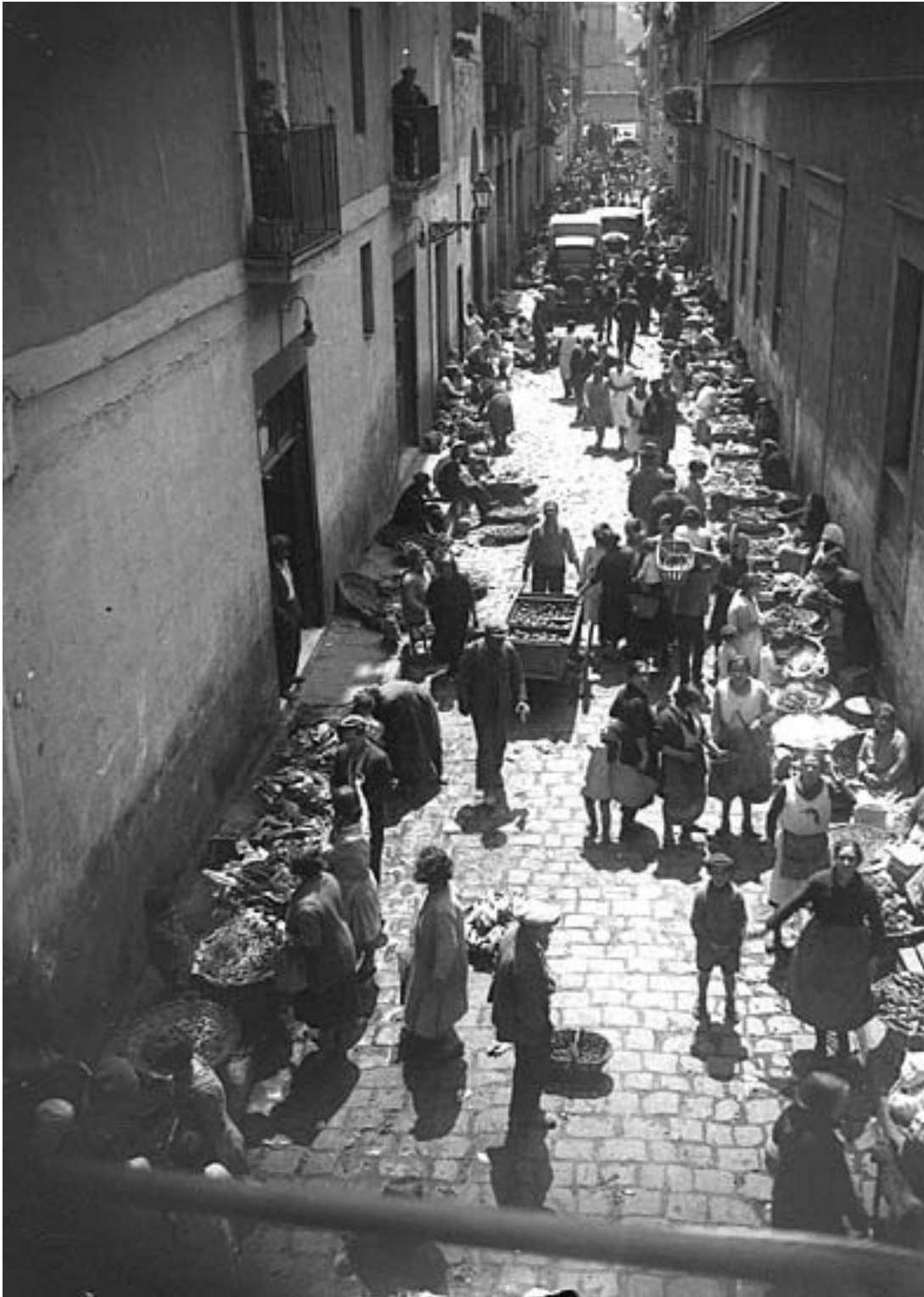
Carrer del Cid des d'un dels pisos del carrer Migdia, Casas i Galobardes. Anys 30
